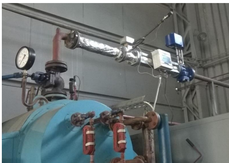
Рисунок 3.9 – Вихровий витратомір «Ирга-РВ» та автоматичний паровий клапан «LDV» RV-ANT40, встановлені на вихідному паропроводі парового котла
